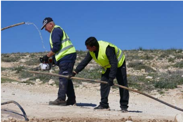
Arbeiter durchtrennen die Wasserleitungen in Masafer Yatta; Foto © EAPPI
